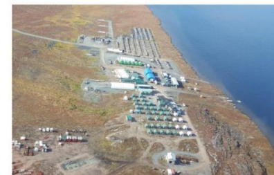
ВАХТОВЫЙ ПОСЕЛОК BACK RIVER GOLD CAMP, КАНАДА
