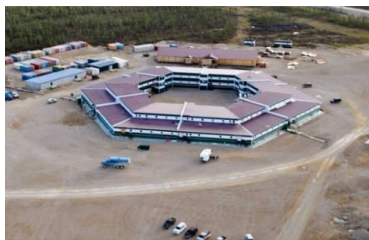
ВАХТОВЫЙ КОМПЛЕКС АЛМАЗО-ДОБЫТЧИКОВ НА 400 ЧЕЛОВЕК ПРИ МЕСТОРОЖДЕНИИ ЭБЕЛЯХ-ГУСИНЫЙ В ЯКУТИИ
