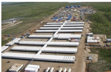
ВАХТОВЫЙ ПОСЕЛОК ВАНКОРСКОГО МЕСТОРОЖДЕНИЯ, КРАСНОЯРСКИЙ КРАЙ
